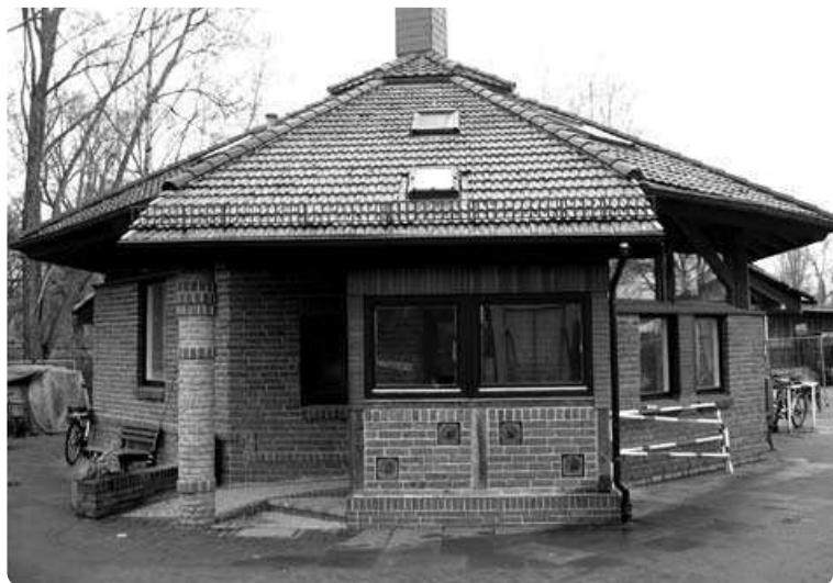
Abb. 29: Umsetzung mit 80% gebrauchten Materialien, Recycling Pavillion Huchting
