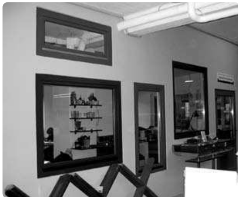
Abb. 47: Kreative Wiederverwendung gebrauchter Fenster
