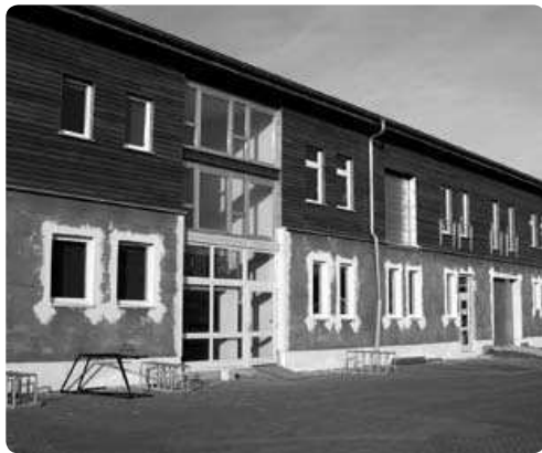
Abb. 53: Bauen mit gebrauchten Fenstern
