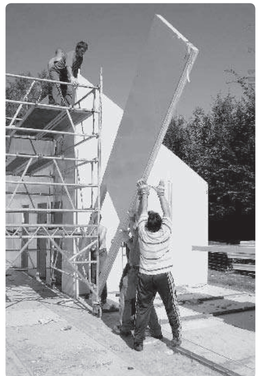
Abb. 5: Schadensfreier Rückbau
