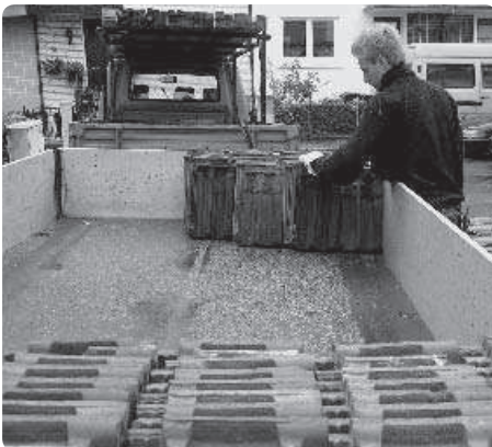
Abb. 9: Gezielter Rückbau für die Wiederverwendung
