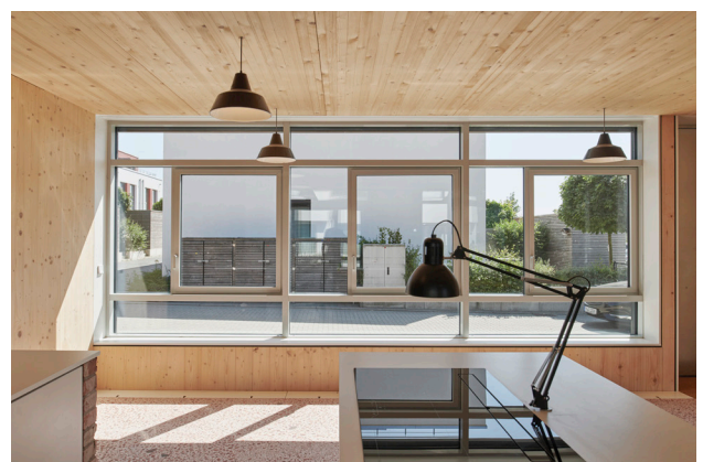
Küche: Massivholzrohbau, gebrauchte Aluminium-Fensterelemente, Laibungsbretter aus alten Messebauplatten, gebrauchte Innenausstattungen
