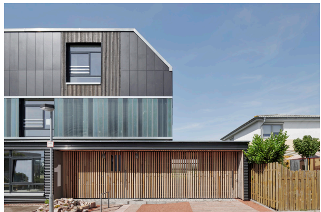
Fassade aus Gebrauchtmaterialien: Gebrauchte Aluminiumfenster, Eternitplatten, Profilbauglas und Wellblech, Holzfassade aus alten Saunabänken
