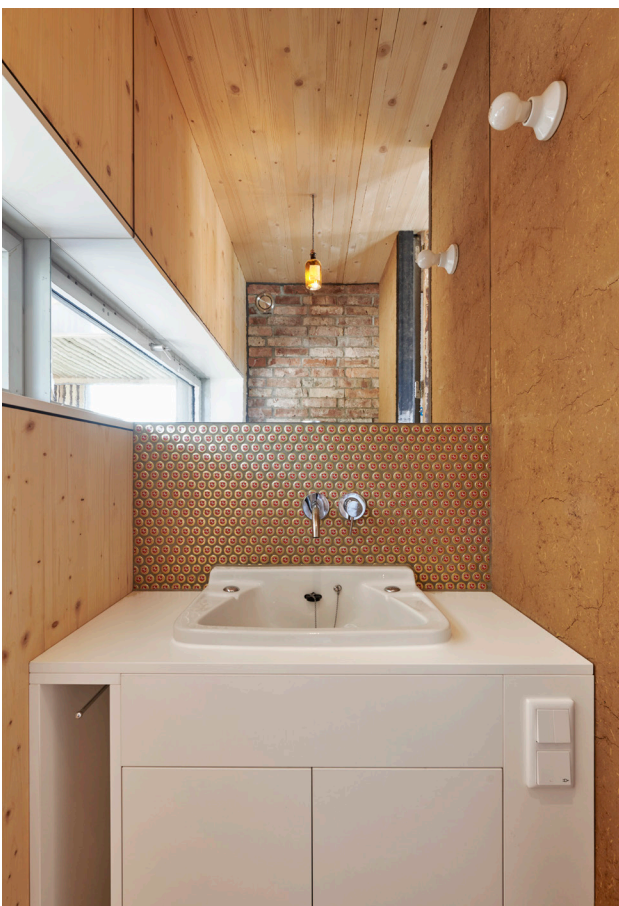
Gäste WC: Kronkorkenmosaik, gebrauchtes Waschbecken, gebrauchte Messebau-Spiegelplatten, Waschtisch aus Messebauplatten, Lehmputz
