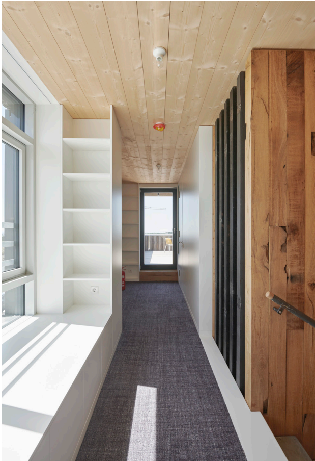
Dachgeschoss: Möbel und Innenwände aus gebrauchten Messebauplatten, Absturzsicherung aus gebrauchtem Stahl, Teppich aus Recyclinggarn
