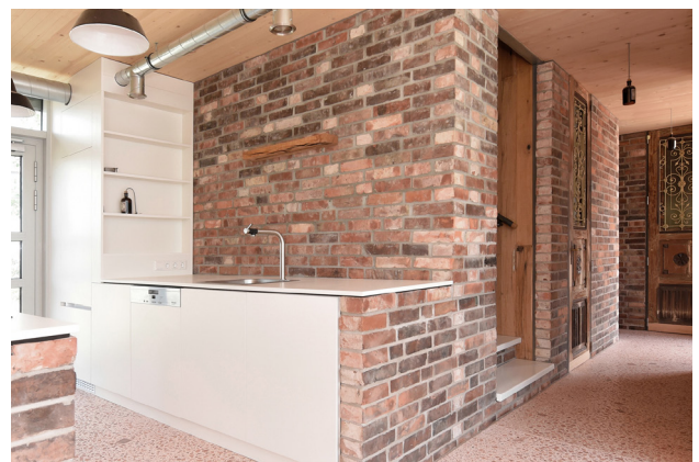
Innenwände aus Abbruchziegeln, Terrazzo "Opus Signium" mit Ziegelsplitt-zusatz, historische Bauernhaustür umgebaut zu Innentüren
